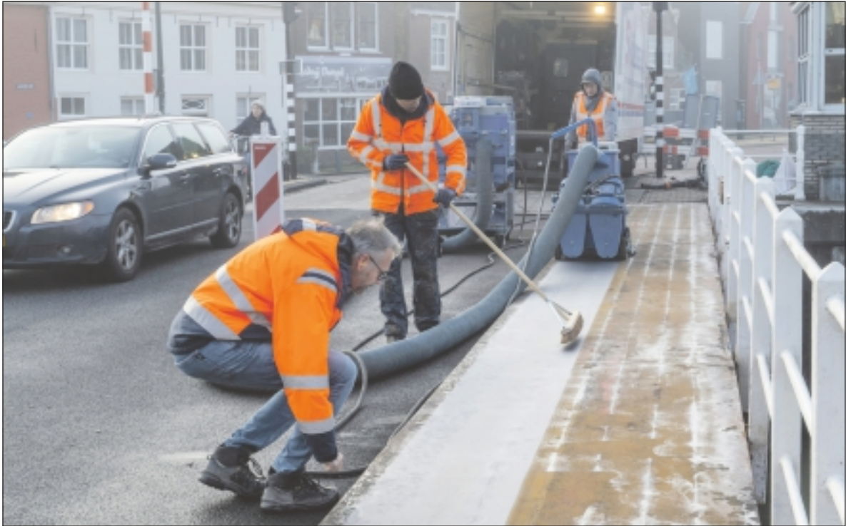
De Boer & De Groot Civiele heeft dinsdag en woensdag de slijtlagen op de 'stoepen' van de Havenbrug vervangen. (Foto: HC - Joachim de Ruijter)
